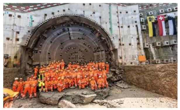
Da das Schadensbild auch nach der Erneuerung durch die Wirkung des hohen Quelldrucks wieder zunahm, entstand die Idee eines "Sanierungstunnels". Dieser soll ab 2021 den Richtung Süden fliessenden Verkehr aufnehmen, während die bestehenden Röhren nacheinander totalsaniert werden.
