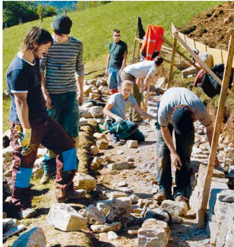
**Trockenmauerbau in Rothenfluh, 1. September 2010.** Bild OG
