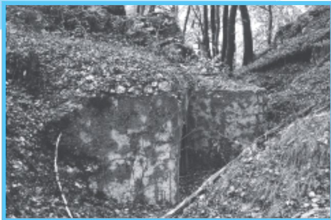
Bauwerke der Fortifikation Hauenstein am Zehntenhübel. Auch 90 Jahre nach ihrer Erstellung sind die eindrücklichen Verteidigungsanlagen noch gut erhalten. (Foto: hrs)
